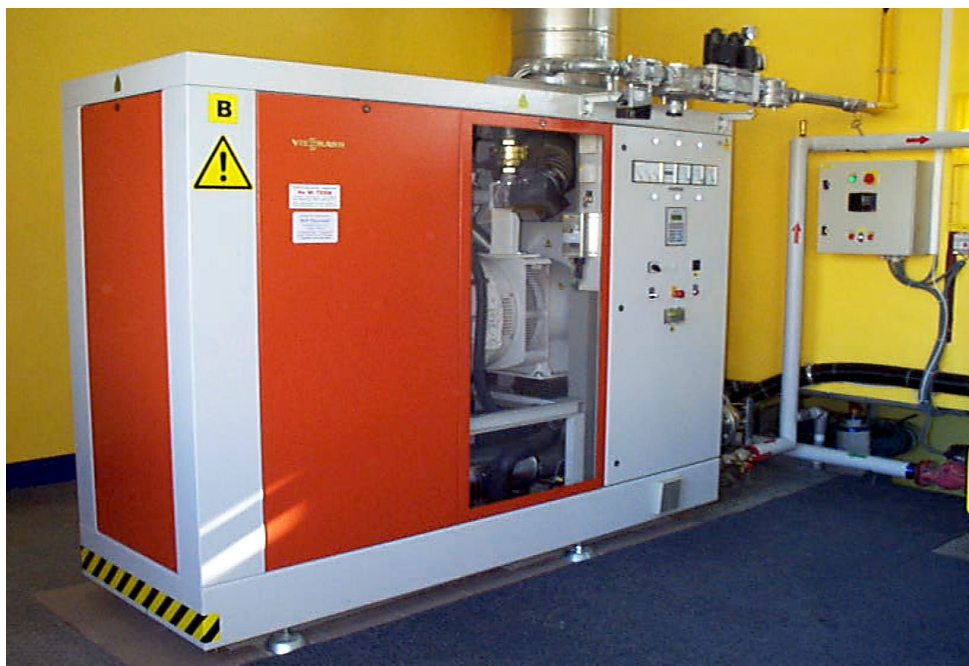
Rys. 1 Moduł ciepno-prądowy BHKW Vitobloc FG 114
